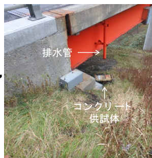
写真-1 暴露実験の様子
