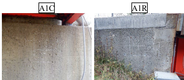
写真-2 塩化物イオン量調査を行った橋台の外観
