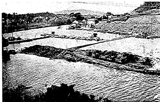
写真第六十一 上流部隆起河床の掘鑿状況。 (5月27日撮)
