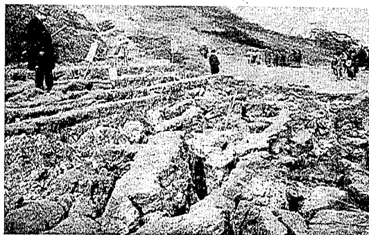
写真第十七 地割箇所が崩壊著しくなる。崩壊する土塊は階段状をなしてゐる。(2月下旬撮)
