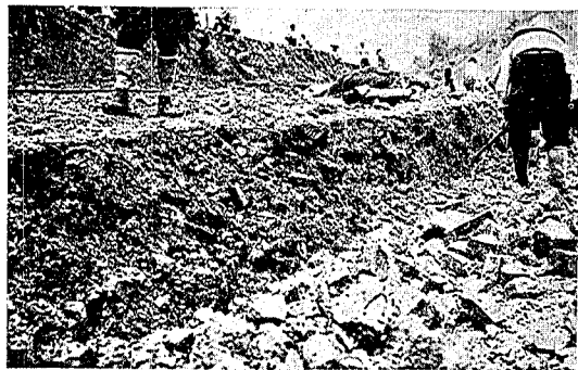
写真第四十九 隆起する道路の中央部 (5月27日撮)
