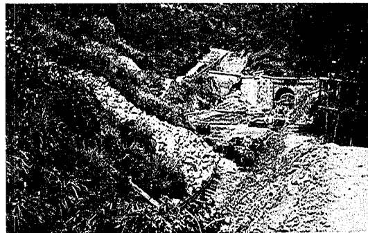
寫眞第六 西口附近に押し出した山崩の先端。下り線のレールが押し曲げられて、線路敷は殆ど埋められ、徒歩連絡道は向って右側に新設された。(7月6日撮)
