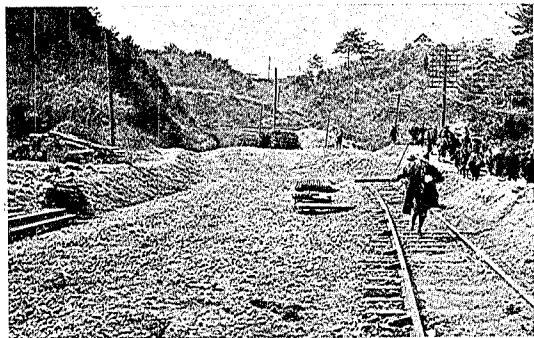
写真第五十八 隧道東口附近の隆起著しくなる。 (3月1日撮)
