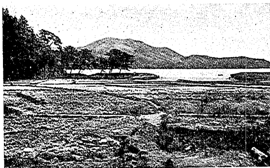
寫眞第七十七 大原村谷川海岸堤防の一部流失。この築堤も寫眞七十六と同様主として砂利より成つてゐた爲に津浪に對する抵抗力が弱かつた。
