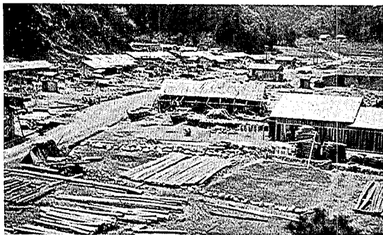
写真第三十四 上閉伊郡鵜住居村兩石。この附近にあつた部落は全部流失したがその後應急用のバラック建築（主として倉庫及工場）が次第に建てられた。（5月27日報）
