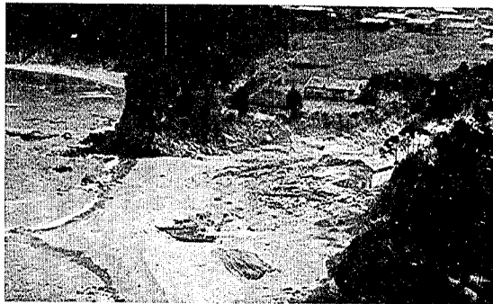
写真第四十九 気仙郡綾里村野々前。綾里灣の奥、白濱に於ては津浪の高さ29 m以上に及んだが大より稍離れて灣の右岸にあるこの地點では浪の高さ最大15.5 mである。写真の南方右の網屋は津浪後に建てたもの。（5月25日撮）
