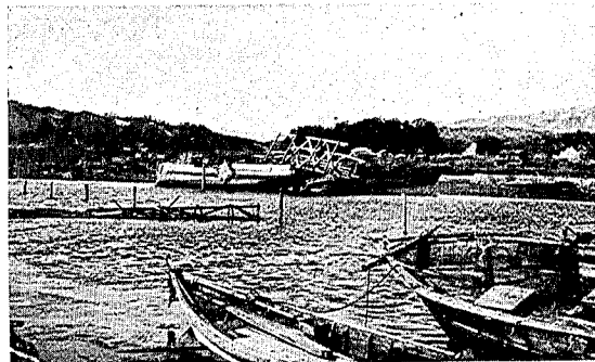
写真第二十四 宮古町。宮古橋の橋桁の一部が船に乗つて上流に運ばれたもの。
