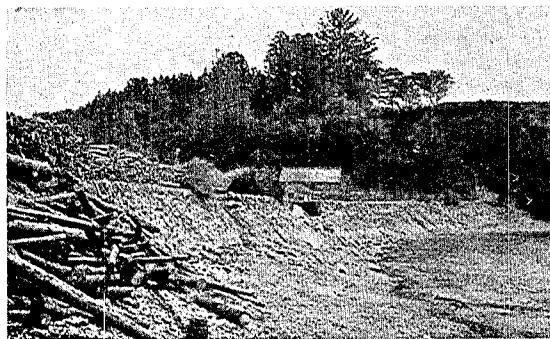
写真第六十九 歌津村伊里前。練袈護岸(高さ約 3 m)の爲 に明治 29 年よりも被害著しく軽減。
