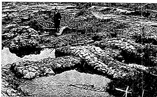
寫眞第十一 普代村普代。茂市川の鐵線蛇籠が寫眞の如く 4 組並置してあつたものが津浪の爲に右岸端の一组が仰向けに上流に倒された。この附近津浪の河底上の高さは約 3.0 m であつて轉覆の原因は漂流物の爲と推定される。
