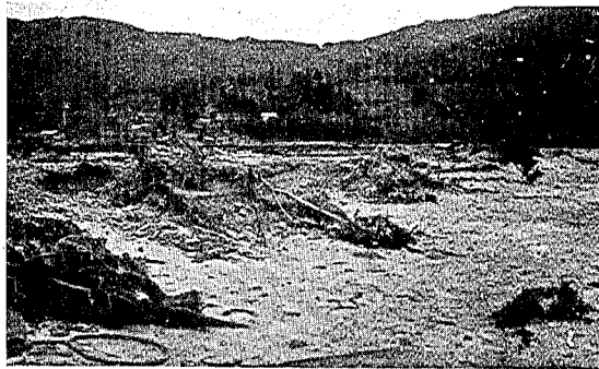
写真第四十七 越喜来村浦濱。海岸に沿つて高さ約1 m、巾約3.5 mの道路築堤がありその外側の巾約4 mの防潮林の松は20年位の齡を經たものであつたが写真の如く根本から全部洗はれた。津浪高最大6.3 m。
