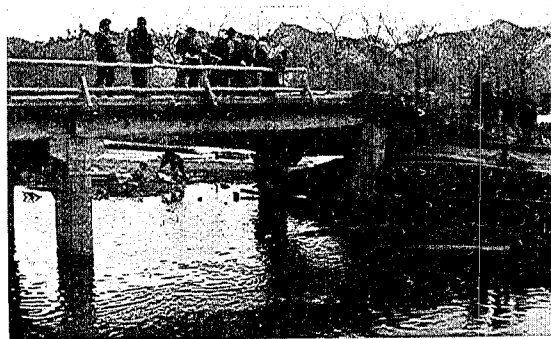
寫眞第三十二 上閉伊郡大槌町。小槌川安渡橋。鐵筋混凝土橋脚が押し流されて來た漁船の爲に破損した。
