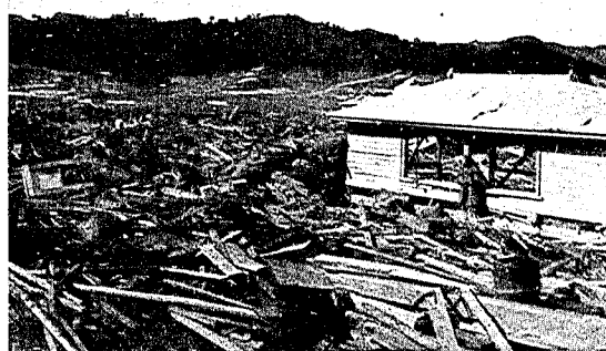
寫眞第二十九 下閉伊郡山田町。津浪が襲来したる最高地點 附近に残された破壊された家屋の残骸。
