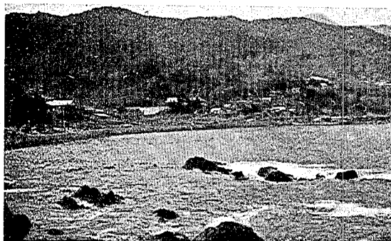
写真第四十二 唐丹村小白濱。写真の如き高さ約 3.3 m の練炭間知護岸は大なる被害を受けなかつたが同時に津浪の勢力が非常に大なるこの土地では大なる功も樹てなかつた。津浪高この附近に於て最大 12.1 m。(5 月 26 日報)
