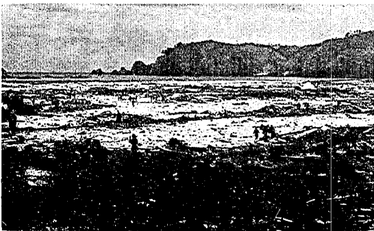
写真第十九 下閉伊郡田老村。此の地帯一面に翳比せる家屋が全部流失した。写真の前方の木材は津浪が襲來した最高地點附近に残されたもの (3 月 6 日報)
