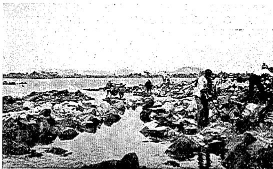
寫眞第六十四 大谷に於ける防波堤築造工事。農林省の匡救工事
