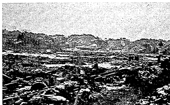
写真第二十 田老村。村落中心地附近。
