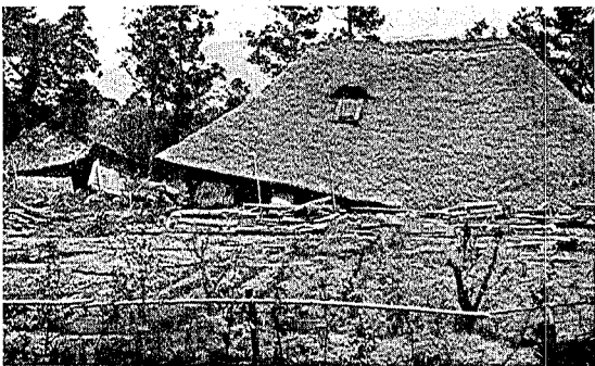
写真第五十八 気仙郡米崎村沼田。海岸に樹木多く之に過ぎられて浪の勢が小となり家屋は多く倒壊した儘であつて流失したものは少い。
