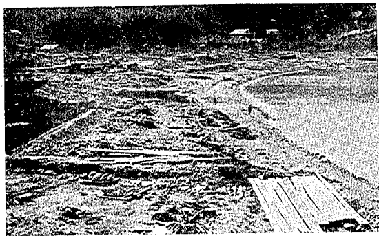
寫眞第六十一 宮城縣唐桑村大澤。半島の首に相當するこの部落は南よりの浪と北よりの浪とが合してこの首部を横斷した。寫眞は崩壊した北側空積護岸。(5 月 23 日撮)
