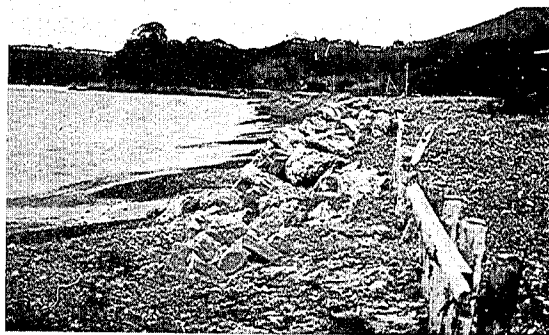
写真第七十二 本吉郷戸倉村波傳谷。線状護岸の破壊。
