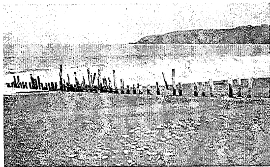
写真第七 久慈町海岸。砂の移動多く同地常盤製鐵所に於て數十萬圓の工費を投じて築いた久慈川河口の新水路は完成通水後一夜にして埋つた歴史がある。写真は津浪の被害ではないがその當時の導流堤の形見である。
