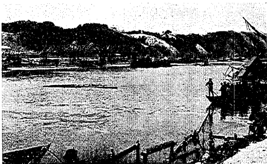
写真第二十三 宮古町、宮古橋。橋脚を流矢物の爲に破壊された。中央の左にあるは残された一部の橋桁。
