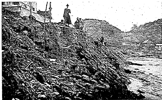
写真第六十七 歌津村名足。高 4.5 m の練袈護岸一部破壊。 この護岸の爲に被害は明治 29 年に比し著しく軽減。(5 月 22 日撮)
