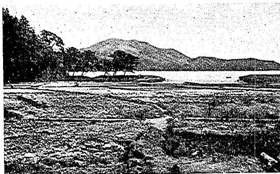
寫眞第七十七 大原村谷川海岸堤防の一部流失。この築堤も寫眞七十六と同様主として砂利より成つてゐた爲に津浪に對する抵抗力が弱かつた。
