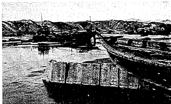
写真第二十二 宮古港。工事中の鉄筋混凝土矢板が押し流された舟の爲に水中の根本で折れた。矢板は斷面 50 \times 20 cm (鉄筋は徑 16 mm のもの兩側に 5 本宛) 長 6.50 m 根入約 3.80 m.
