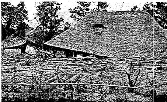
写真第五十八 気仙郡米崎村沼田。海岸に樹木多く之に過ぎられて浪の勢が小なり家屋は多く倒壊した儘であつて流失したものは少い。
