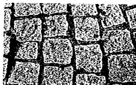
K I (小鋪石道) 路面
