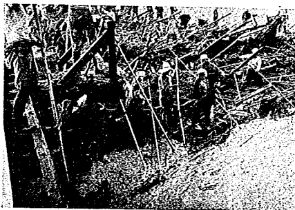
圖-18 左門殿川阪神電車鐵橋脚に堆積した漂流物、橋の危険を救ふ爲に多數の工夫をかけて除却に努めてゐる。
