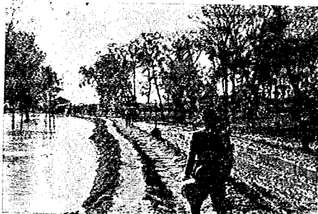
写真-9 (出水による道路の泥濘)
