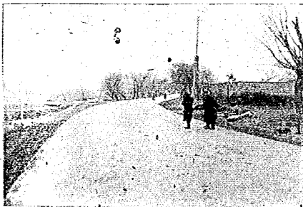
寫眞-15 (アスファルト鋪装の破損個處の調査)
