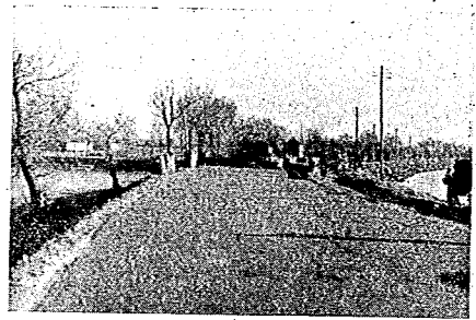
寫眞-14 (乳劑の表面處理)
