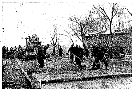
写真-11 (コンクリート舗装工事)
