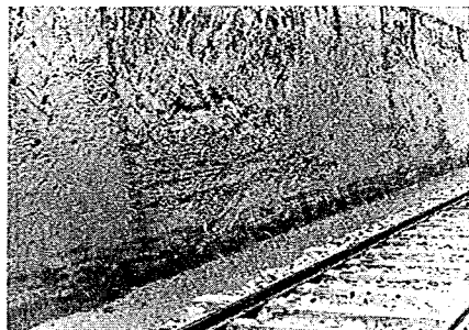
写真-8 (鐵道の法面)
