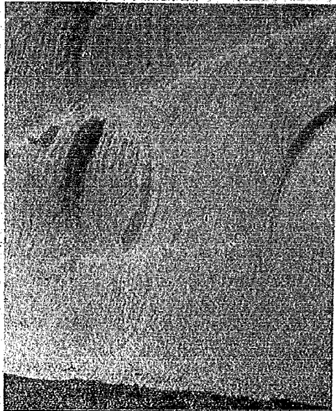
(2) 削抛除雪車による開鑿された雪壁
