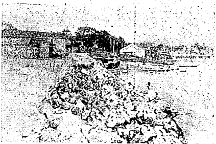
寫真—69 三國港防波堤
