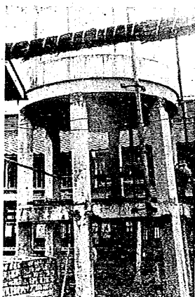
寫眞—86 大聖寺町内精鍊 工場水槽
