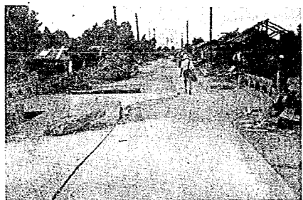
写真-26 幾久附近のコンクリート舗装道路
