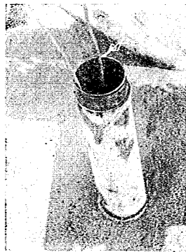
写真-5 間隙水圧計の設置
