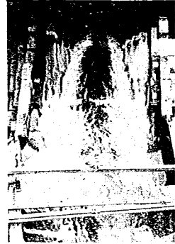
写真—36 流量 194 l/sec. 両側各 2 門の溢流部門扉開放
