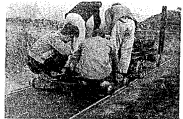
写真-3 測定土地整地
