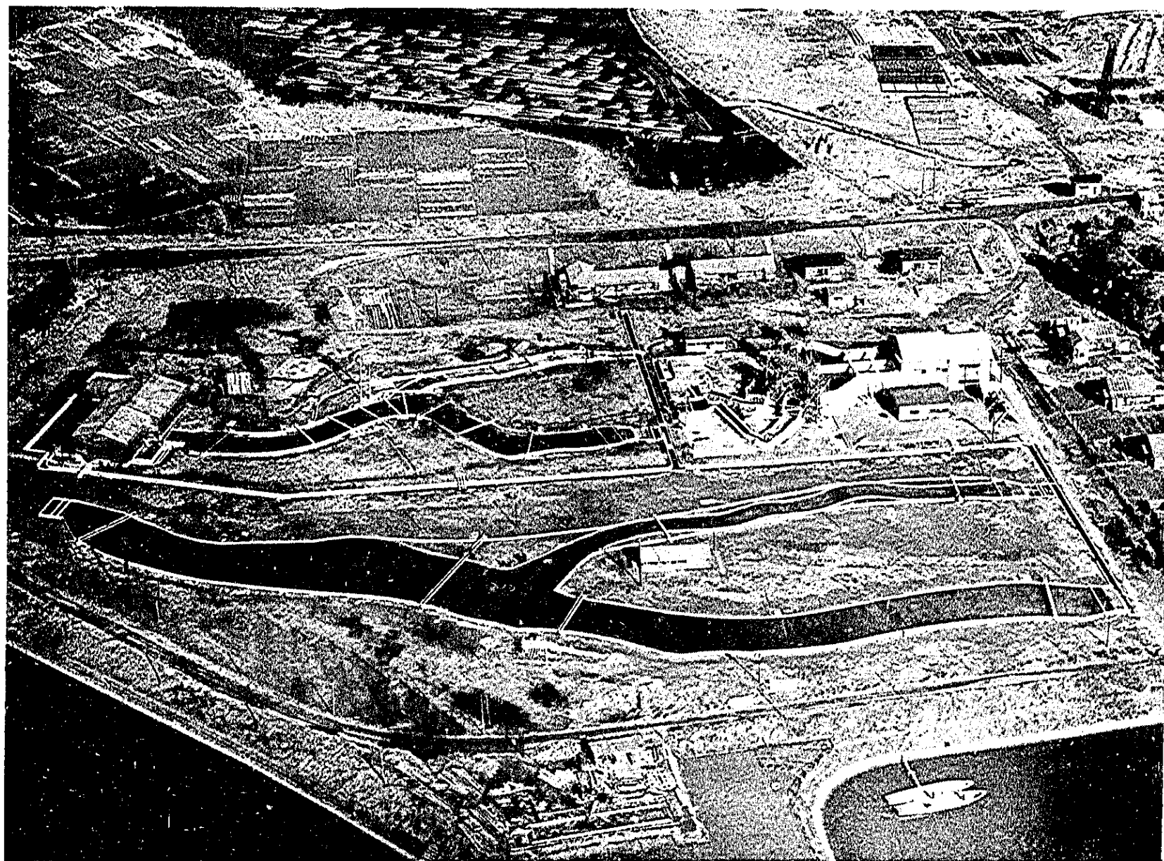
写真—2 篠崎分室欄内全景
