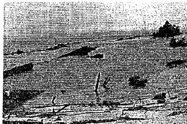
写真-8 東実録欠壊部
