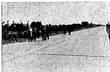
写真-7 実験場として使用した舗装道路
