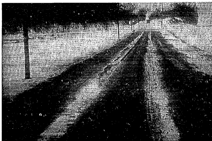
写真—5.2 1 級国道 7 号線（秋田県山本郡浅内村）において 盛土路面形状 に防除雪機能のあることが確認される状況
