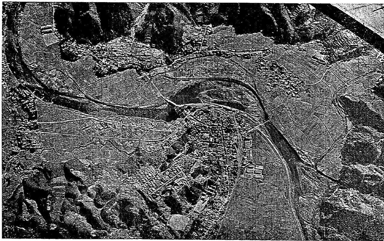
写真-5(a) 大仁付近の航空写真(洪水前)
