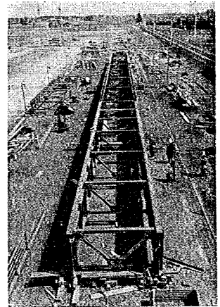
写真 - 3 工場仮組立の状況
