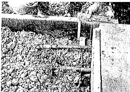
写真-9 伸縮計の鋼棒を埋めこむためのブリキ管
