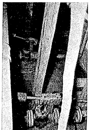
写真-3 濾過速度調整器 (ダブルシート型)
