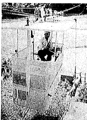
写真-5 第5回吊かご（側面）
