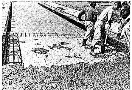
写真-11 第2回試験舗装鉄籠の埋設状況
