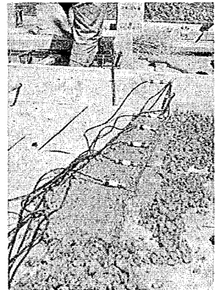
写真-31 カールソンひずみ計の埋設状況
