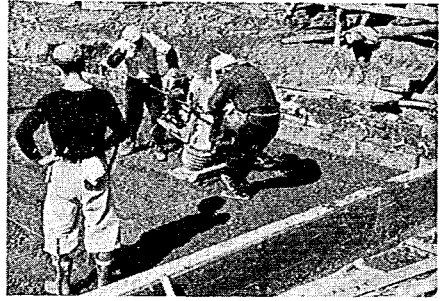
写真-2 振動板による路盤転圧
