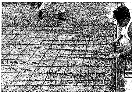
写真-9 第2回試験舗装 鉄網No.2埋設状況
