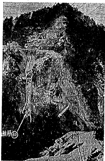
写真-7 左岸アパートメント付近 (掘削後を示す。左方よりの溝は断層(30))
