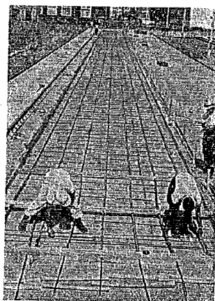
写真-1 縦方向版の PC 鋼より線配置
