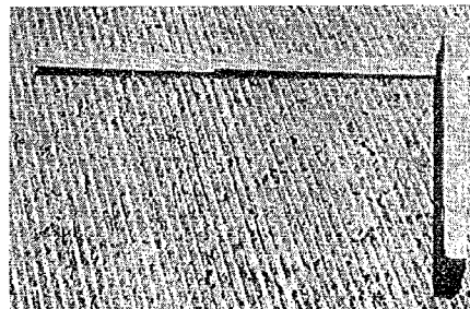
写真-6.2 ハイドロブレイニング対策の溝 (1/8"×1/8", 3/8" 間隔)
