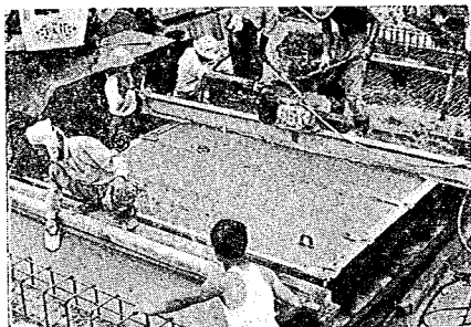
写真-4.4 コンクリート作業
