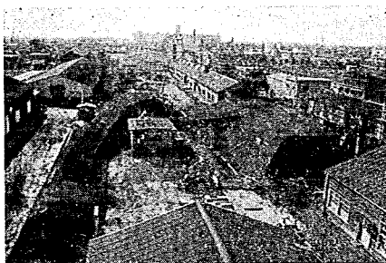
A 盛土：右側手前 B 盛土：右側後方 C 盛土：左側
