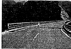
写真 2-9 擁壁の変位の沈下と前への傾き(⑥地点)
