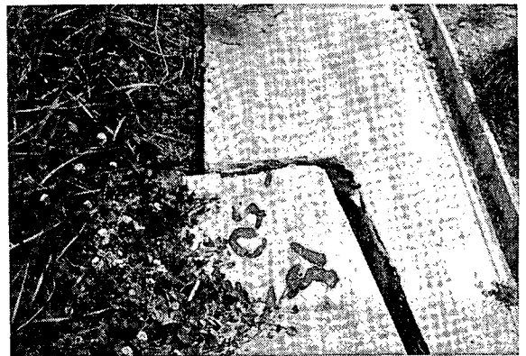
写真-4・1(c) 向井急傾斜地(擁壁工の滑動)
