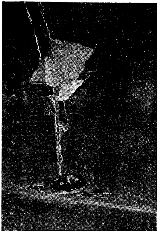
写真-7・3 覆工の継目に生じた剝離
