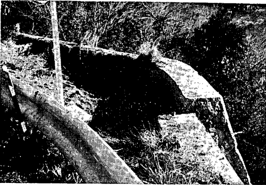
写真-6・9 ブロック積擁壁のずれ(修善寺下田線, 湯ヶ野)
