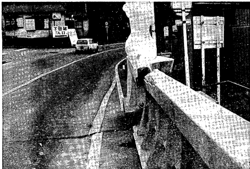
写真-7・20 新下田橋高欄の破損
