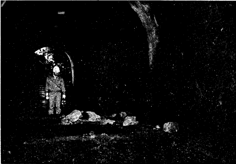
写真-7・9 白田トンネル無巻区間の落石
