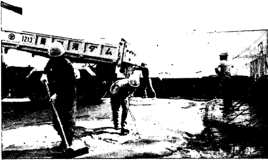
写真-3-4 人力によるモルタル敷均し
