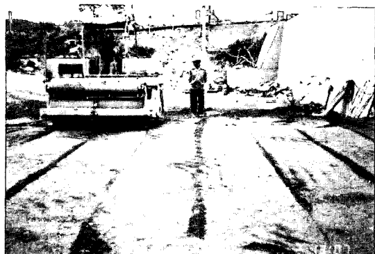
写真-3・11 振動ローラによる転圧
