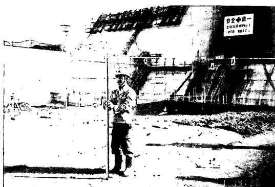
写真-3・12 レベルによる沈下量の測定
