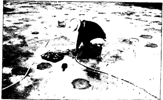
写真-3・3 底盤の非接触型変位計の設置
