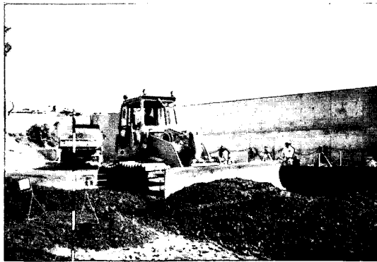
写真-3-6 ブルドーザによる撒き出し
