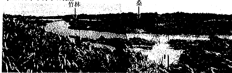
写真-5・1 洪水前後の河道状態の比較 (28.4km地点左岸より下流方向を望む)
