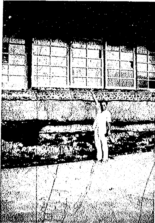
写真-2.4 壊れたホテル内の地盤高 (1988年11月撮影)
