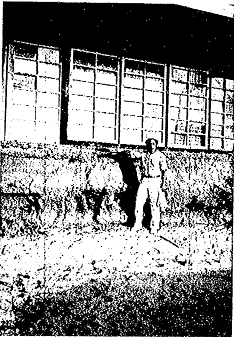
写真-2.3 壊れたホテル内の地盤高 (1987年3月撮影)
