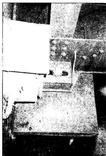
写真-7.40 大岩橋沓座復旧状況
