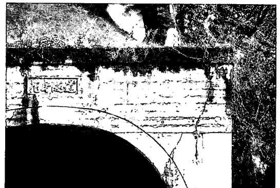
写真-7.49 花房トンネル坑門の亀裂被害状況
