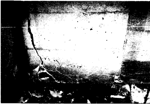
写真-7.33 黒瀬橋のRC桁端の破損
