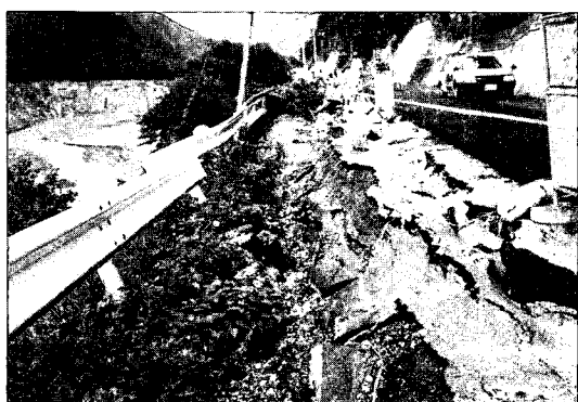
写真-7.3 路肩の崩壊 (村道1号線)
