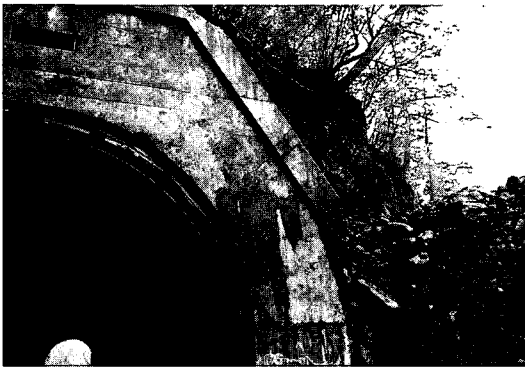
写真-7.45 滝越側坑門の亀裂
