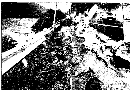
写真-7.3 路肩の崩壊 (村道1号線)
