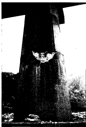
写真-7.18 松原橋RC橋脚の破損 (下流側)
