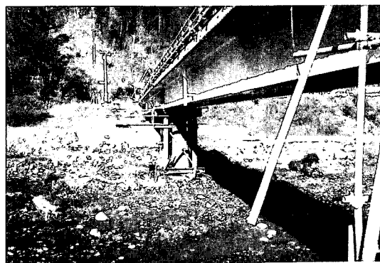
写真-7.29 松原橋応急復旧状況
