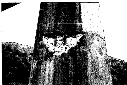
写真-7.19 松原橋RC橋脚の破損 (下流側)
