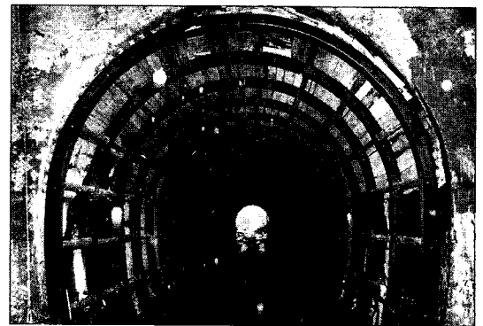
写真-7.48 水ヶ瀬トンネルの応急補強 (滝越側入口から)
