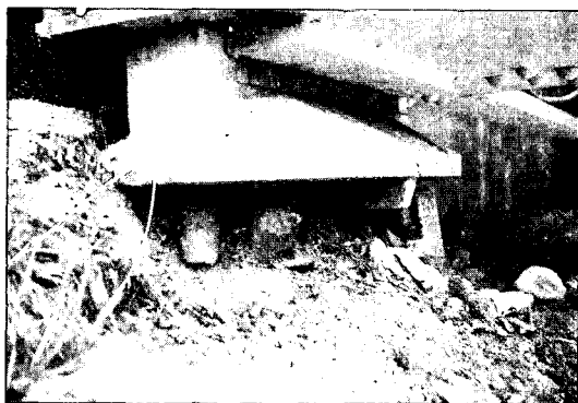
写真-7.38 大岩橋の支承アンカーボルトの破断 沓座コンクリートの破損 (右岸側橋 台上, 下流側)
