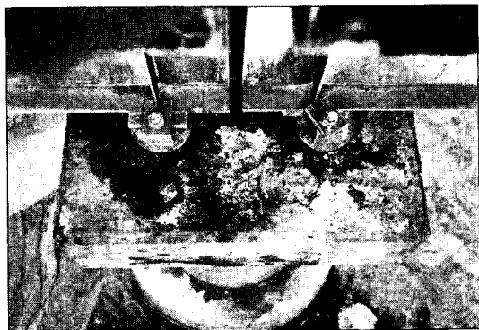
写真-7.28 松橋の支承浮上り防止装置の回転(橋脚上)
