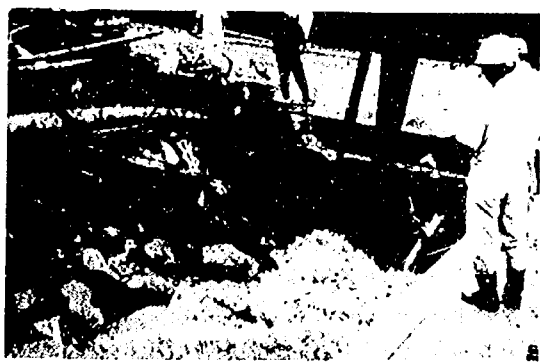
写真-1.2 土石流とともに流下した流木により閉塞した国道のボックスカルバート（京都府和束町，木津川右支川間垣外川，昭和61年7月）
