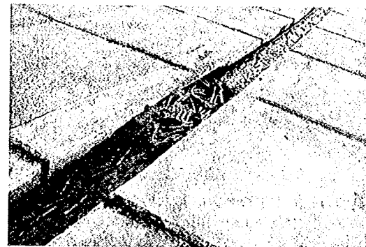
写真-3.9 扇状地内水路に設置された流木止めによる土石流先頭部の流木の捕捉
