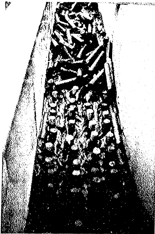
写真-3.5 扇状地上流水路内での土石流及び流木の流下状況
