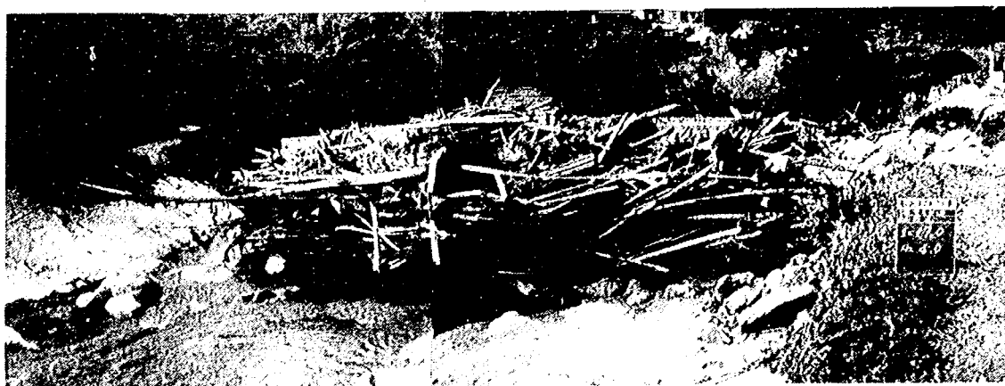
写真-1.9 流木による閉塞による橋梁の破壊（布目橋、京都府笠置町、木津川左支川布目川、昭和61年7月）
