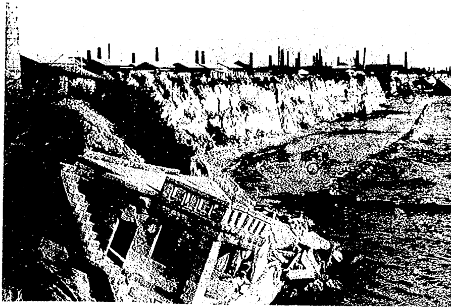
写真-2.1 江井ヶ島地先の東側の海岸状況 (1953年)
