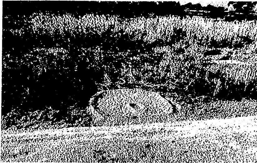
写真-2.5 河川堤防の法尻に設けた液状化に伴う噴砂（河川施設No.6）
