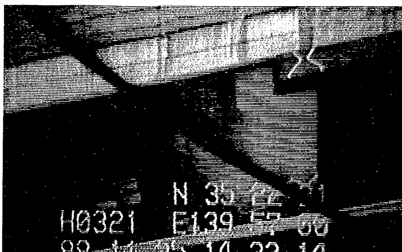
写真-2.9 写真-2.1に示した固定支承上の PC 桁及び RC 橋脚の模擬地震被害を高度321m から撮影したビデオ画像
