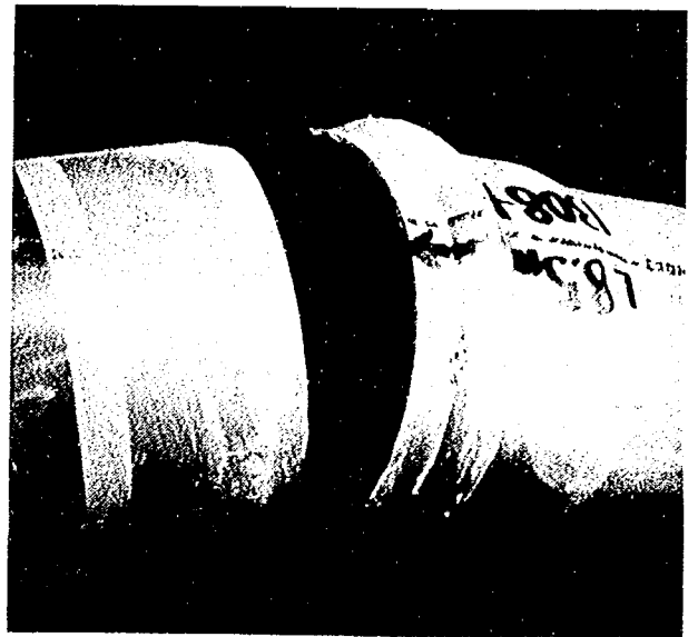
写真-5・4 標茶町の本管継手の破損状況(標茶町提供)
