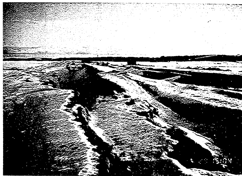
写真-6・19 統内築堤の被災状況
