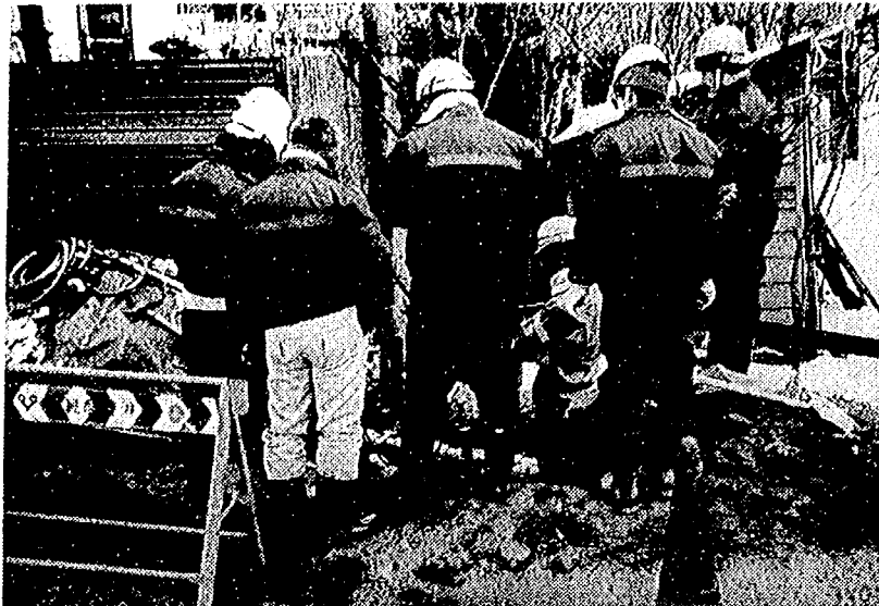
写真-11・1 ガス施設の復旧作業状況（釧路市緑ヶ丘）
