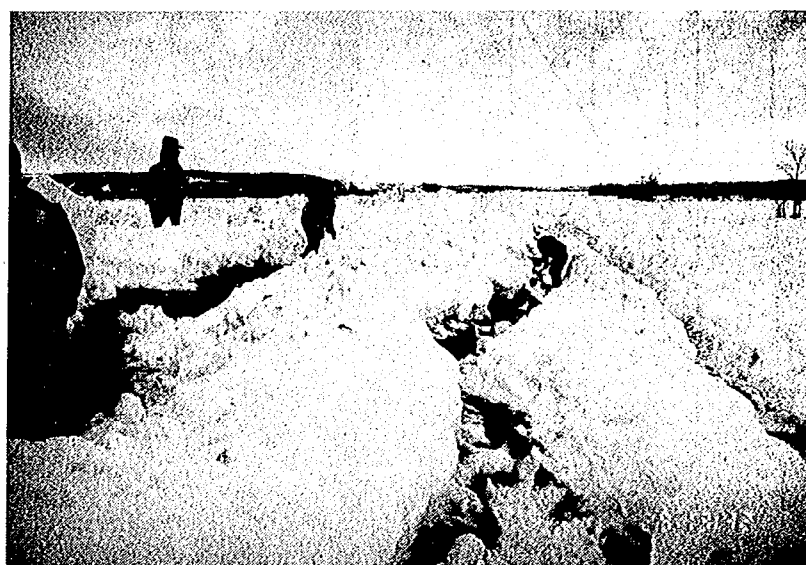
写真-6・18 幌岡築堤の被災状況
