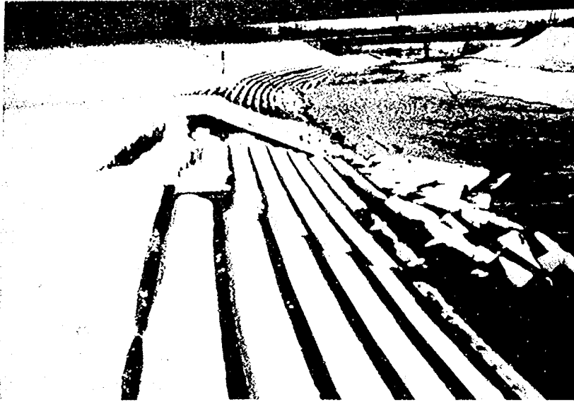
写真-6・11 茂雪裡川親水護岸の被災
