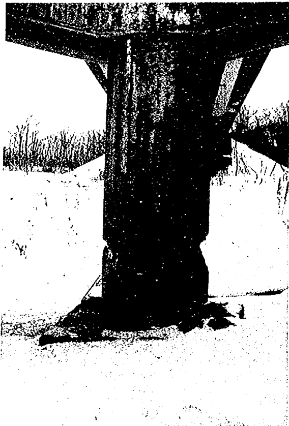
写真-10・11 P2 橋脚の損傷 (依田橋)
