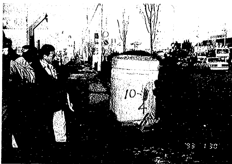
写真-5・3 釧路町のマンホールの浮上がり状況
