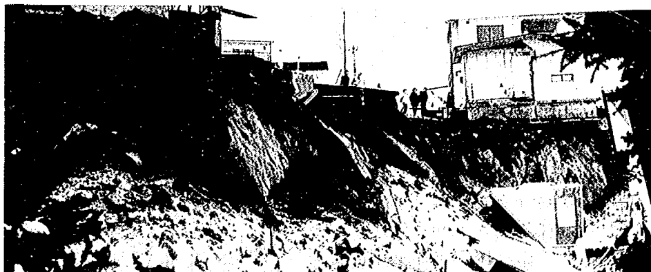
写真-8・2 緑ヶ岡6丁目の被災状況（写真右側の家屋は滑落崖上部から崩落したもの）
