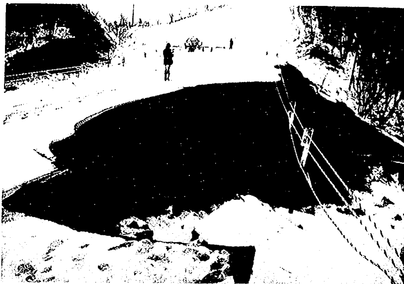
写真-9・8 阿歴内の盛土の崩壊状況
