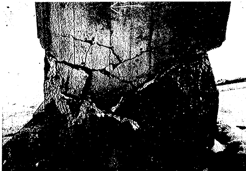
写真-10・12 被害部分のクローズアップ (依田橋)
