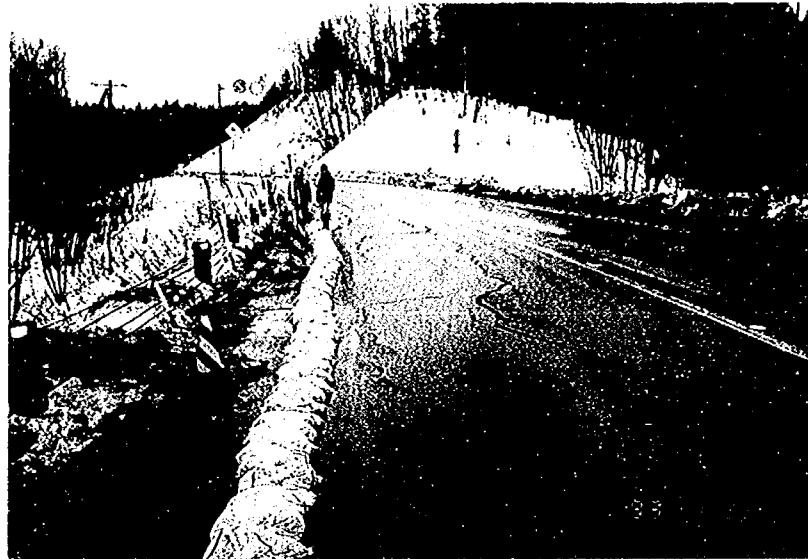
写真-9・9 国道44号深山の厚岸側の盛土の状況
