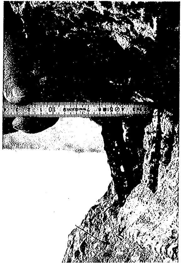
写真-10・13 主鉄筋の破断 (依田橋 P2 橋脚)
