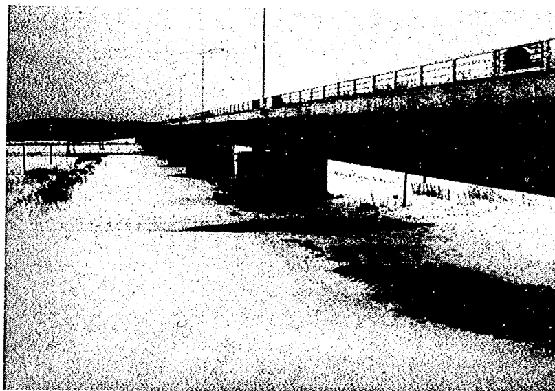
写真-10・31 十勝河口橋
