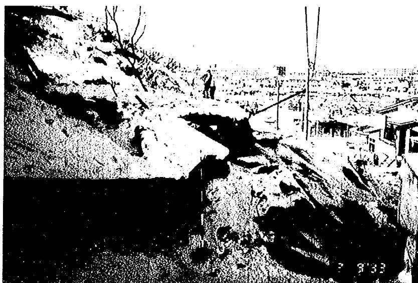
写真-8・3 材木町2の被災状況
