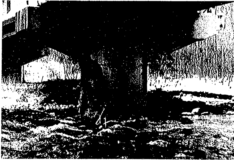
写真-10・18 P3橋脚のコンクリートの剥離 (松之恵橋)
