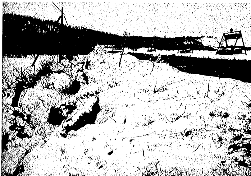
写真-9・14 道道阿寒標茶線鶴居村鶴厚内橋周辺の両盛土のり面の崩壊状況
