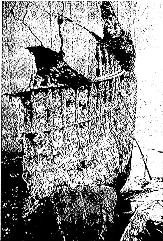
写真-10・19 主鉄筋の面外方向へのはらみ出し (松之恵橋)
