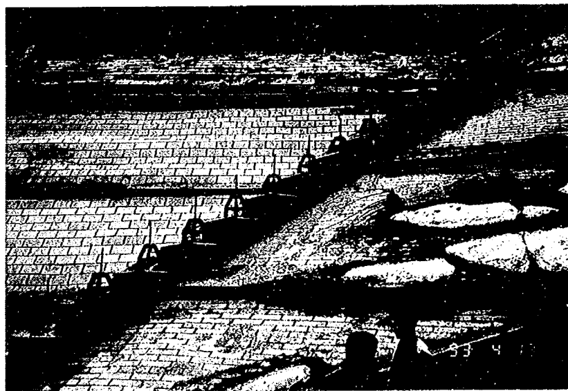
写真-7・2 左岸地山上流部法面の張ブロックの波打ち変状 (門別ダム)
