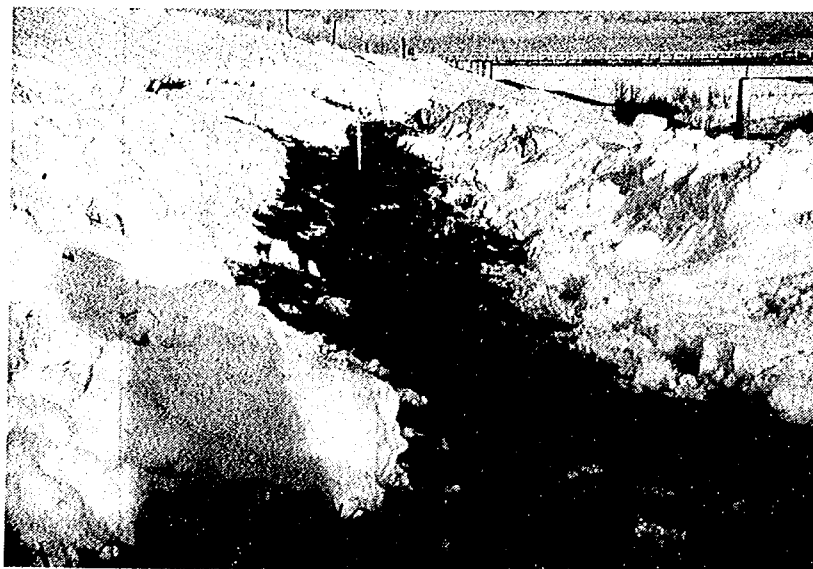
写真-6・21 牛首別川左岸 KP 0.6~1.3 堤外側のり面の被災状況
