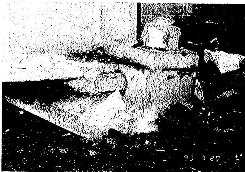
写真-11.7 新有川橋A2橋台沓座モルタルの破壊
