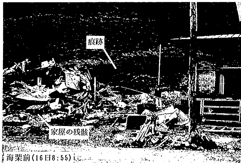
写真-4.19 津波により集積された家屋の残骸
