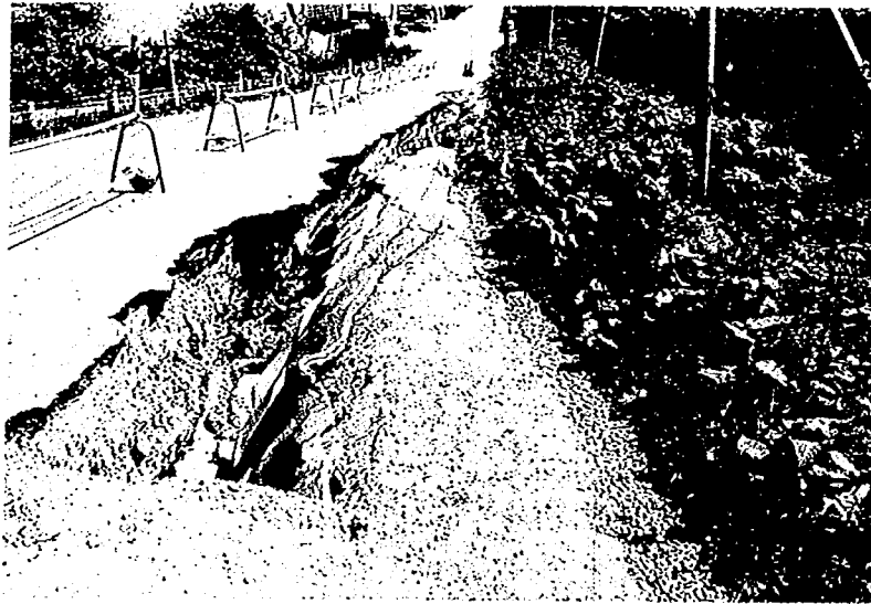
写真-10.9 道道奥尻島線米岡の盛土崩壊
