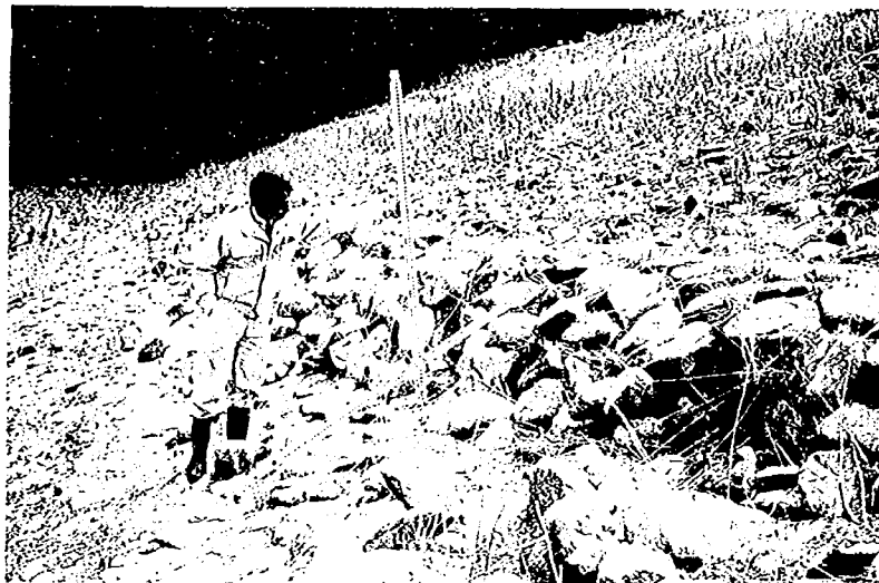
写真-8.8 堤体上流法面の延長約40mにわたる段差約1mのはらみだし(丹羽生嶺ダム, 7月22日撮影)
