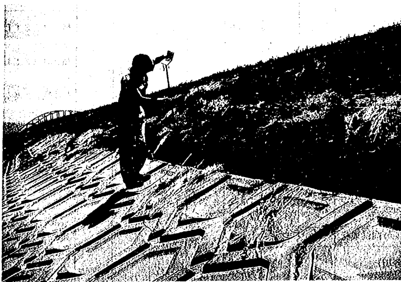
写真-7.3 尻別川左岸大曲築堤の高水護岸すべり破壊状況
