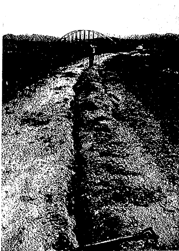
写真-7.1 尻別川左岸大曲築堤の天端の 縦断亀裂状況
