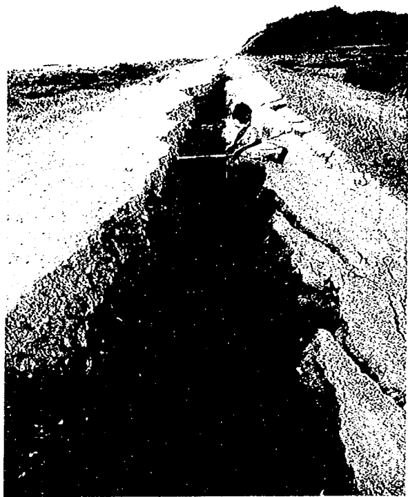
写真-7.7 後志利別川右岸豊岡築堤の被害状況
