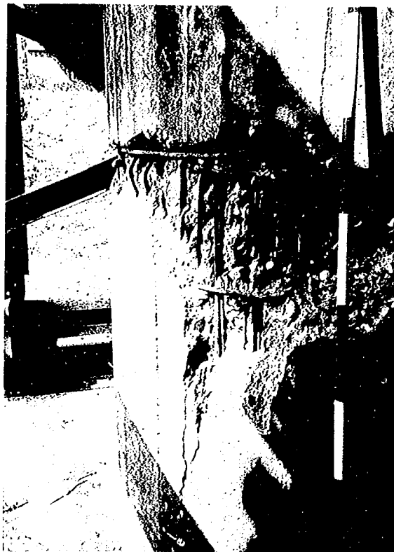
写真-11.27 元瓜谷橋の橋脚の損傷
