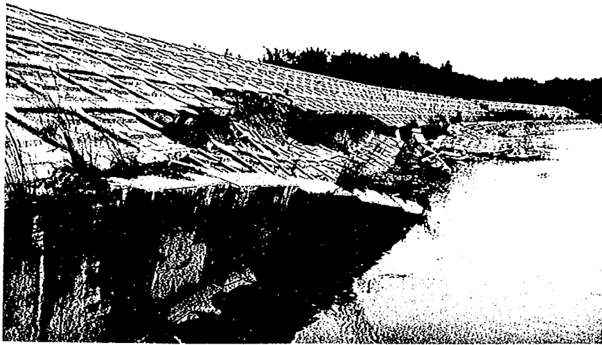
写真-7.13 後志利別川右岸 KP. 11.0付近の低水護岸の被害状況
