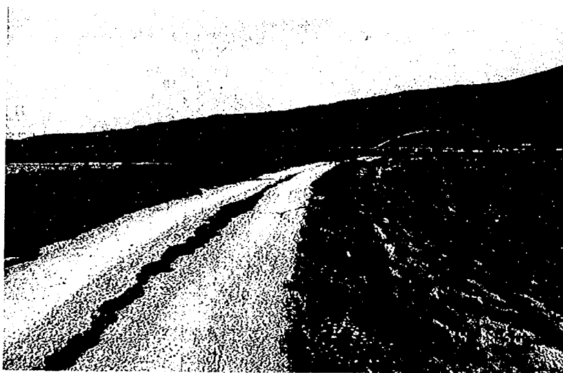
写真-7.4 尻別川右岸初田築堤(中村その1地先)の天端の縦断亀裂状況
