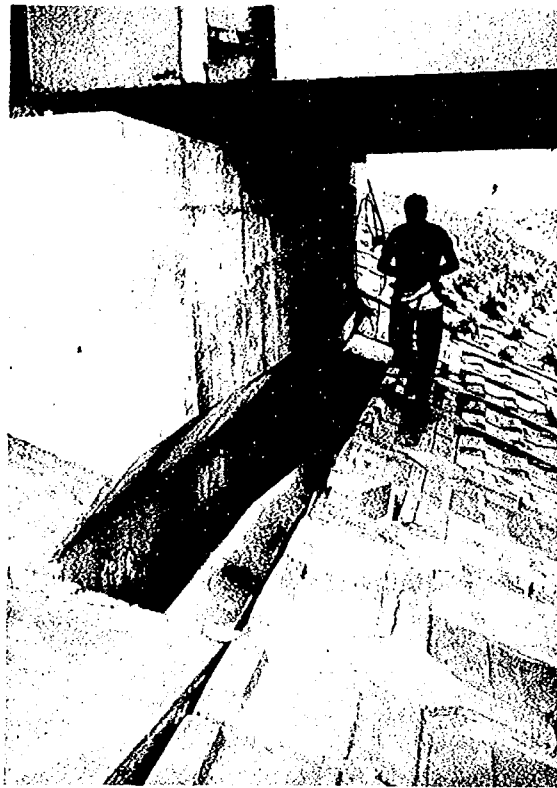
写真-11.19 柳崎橋橋台の護岸の移動（橋台前面）
