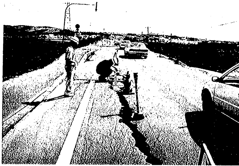
写真-10.8 国道229号江差町柳崎における盛土被害 (北海道開発局函館開発建設部による)
