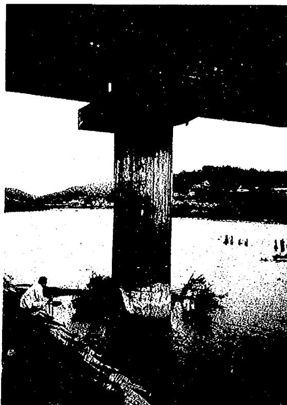
写真-11.10 基栄橋P4 橋脚の損傷 (下流側から)
