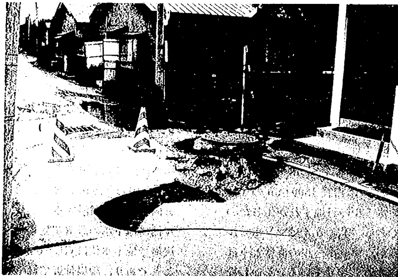
写真-6.2 地震により浮上したマンホール(上磯町七重浜)
