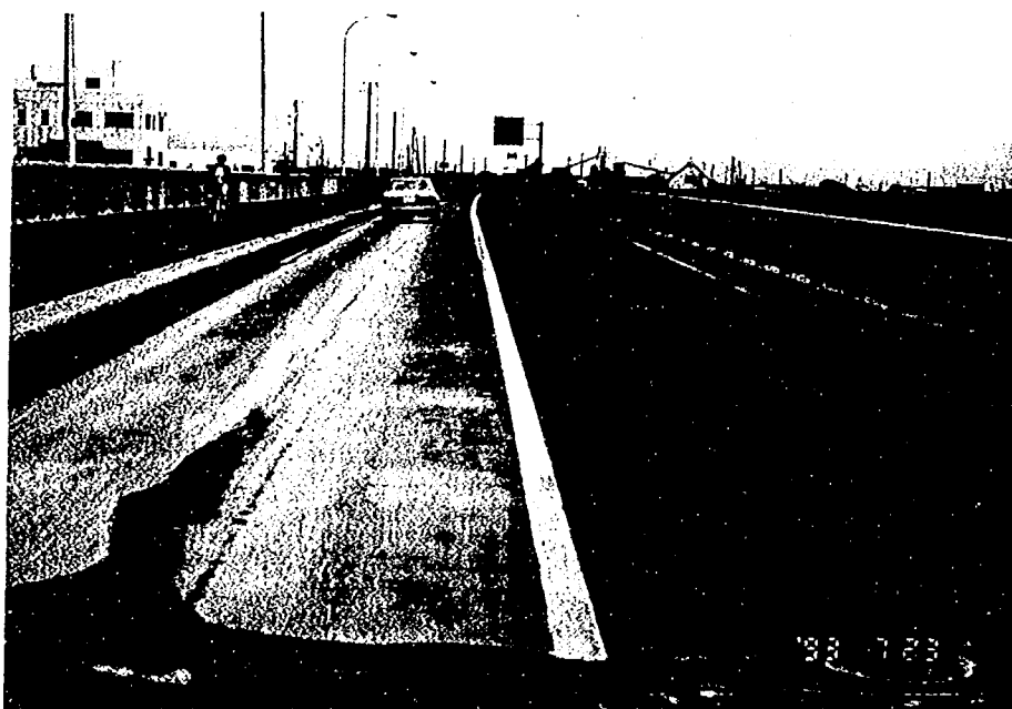
写真-11.24 長万部橋の橋脚傾斜に伴う路面の曲がり (A1橋台側より)
