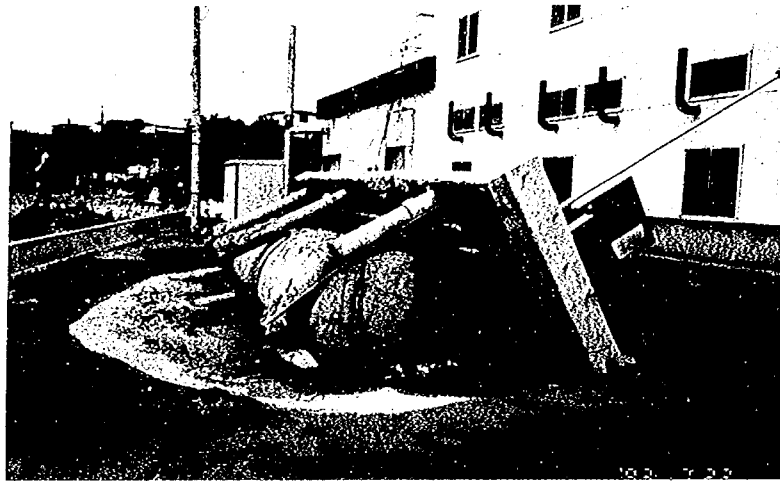
写真-5.8 北海道化学工業の地下タンクの浮上
