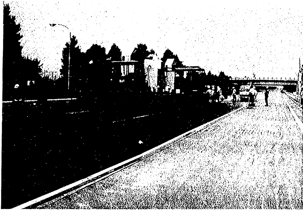
写真-5・1 舗装の施工状況
