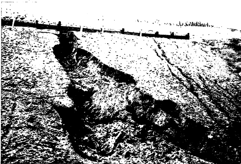
写真-2.4 盛土のり面の表面侵食の例
