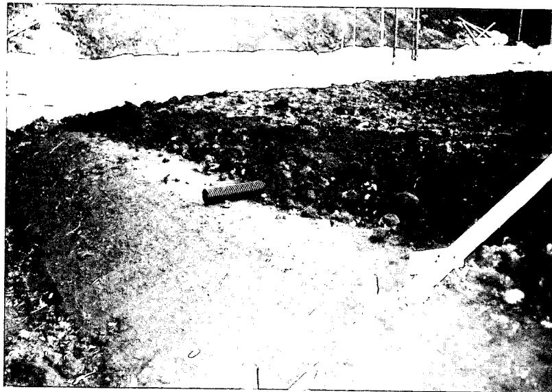
写真-4.3 火山礫フィルター
