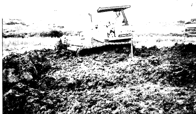
写真-4.5 掘削・運搬後の盛土材料 (刈和野バイパス)
