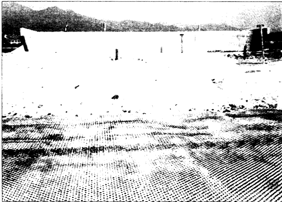
写真-2.6 軟弱地盤上の盛土の補強工法
