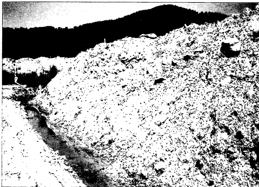
写真-4.7 掘削発生土の仮置場の状況（八木バイパス）
