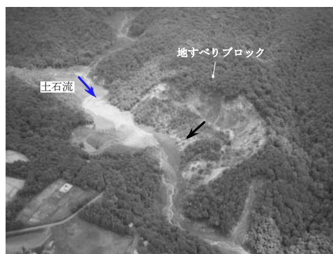
写真-2.53 駒の湯地すべりの全景
