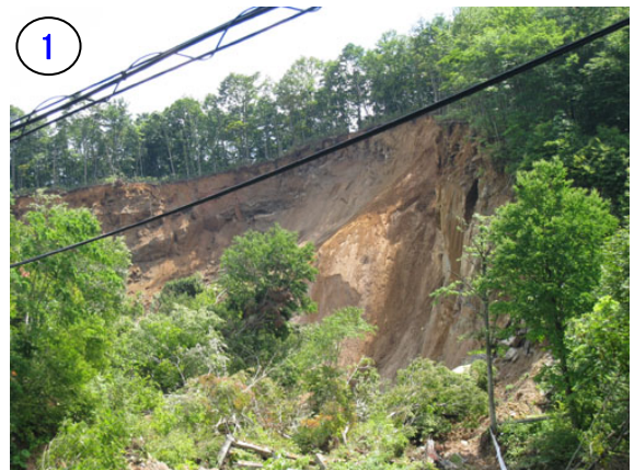
写真-2.36 頭部滑落崖 (2008年7月15日撮影)
