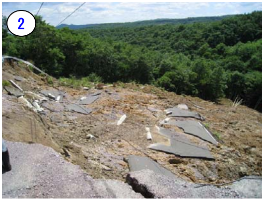
写真-2.33 崩壊土砂の堆積状況 (2008年7月15日撮影)
