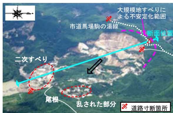
写真-2.1 地すべり全景 (2008年6月15日空撮)
