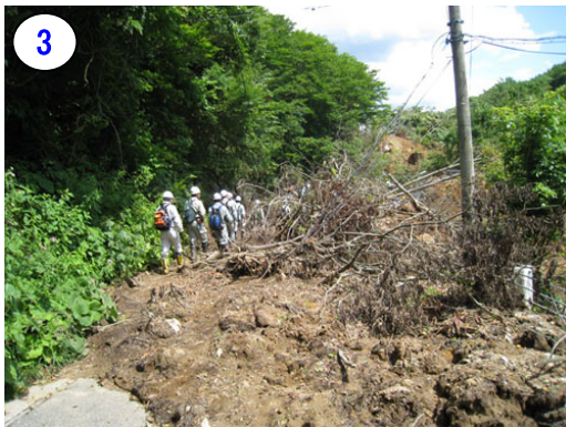
写真-2.38 県道に堆積した土砂 (2008年7月15日撮影)
