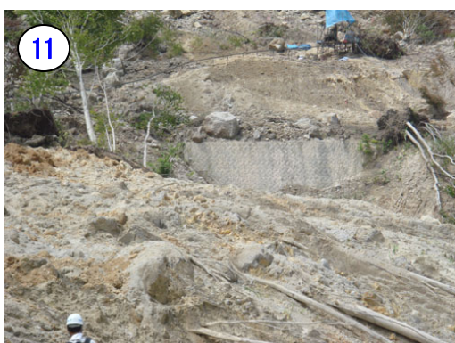
写真-2.23 市道のブロック積擁壁 (変状なし) (2008年8月9日撮影)
