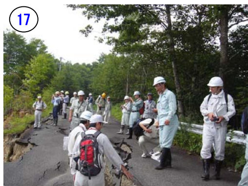
写真-2.29 御沢支川の崩壊による市道の亀裂 (2008年8月9日撮影)
