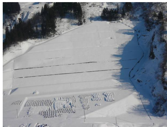
写真-4.9 斜面崩壊（東竹沢）
