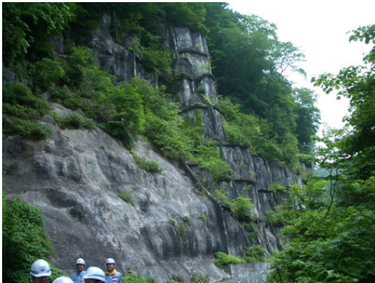
写真-2.44 T-19 地区切土法面（2008年6月22日撮影）
