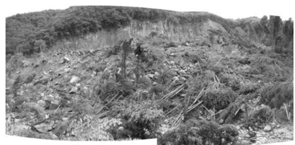
写真-4.5 横断②付近の侵食によって形成された溝の側岸 (2008年6月30日撮影；右岸側)
