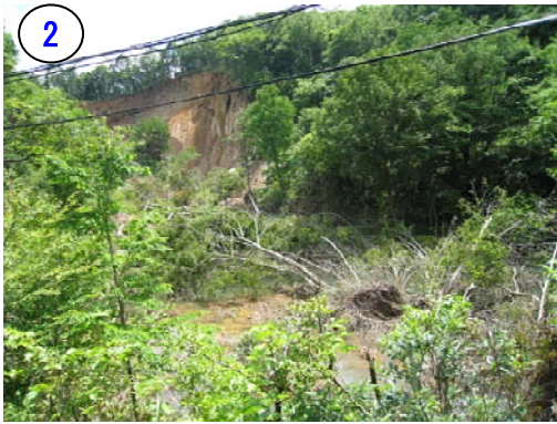
写真-2.37 河道閉塞箇所 (2008年7月15日撮影)
