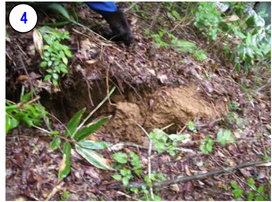
写真-2.14 市道北側の林の連続した新しい 開口亀裂(2008年6月22日撮影)
