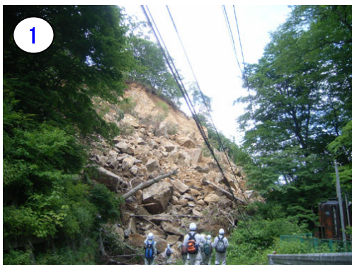
写真-2.40 終点側から見た地すべり末端部の状況 (2008年7月15日撮影)
