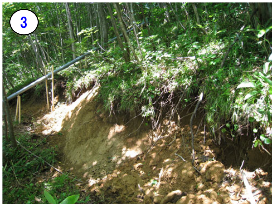
写真-2.34 滑落崖上部斜面に発生した亀裂 (2008年7月15日撮影)
