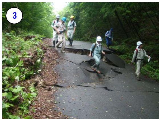
写真-2.13 道路に生じた段差 (2008年6月21日撮影)
