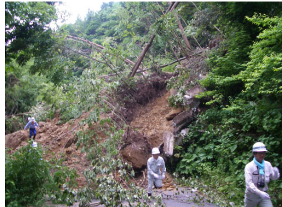
写真-2.46 T-13 地区地すべり（2008年6月22日撮影）
