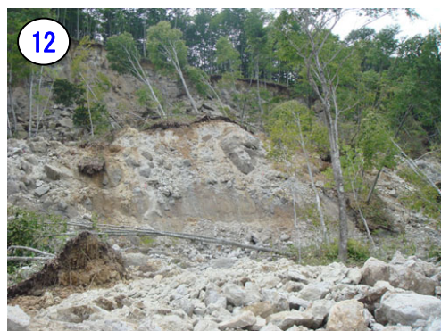
写真-2.24 A-A断面付近の頭部滑落崖 (円弧すべり) (2008年8月9日撮影)
