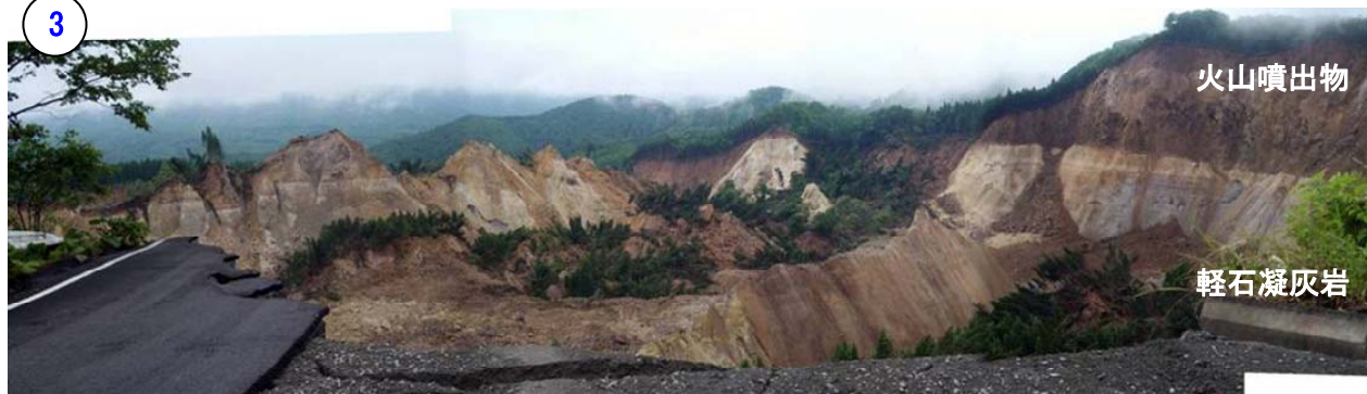
写真-2.2 地すべり上部斜面（2008年6月22日撮影）
