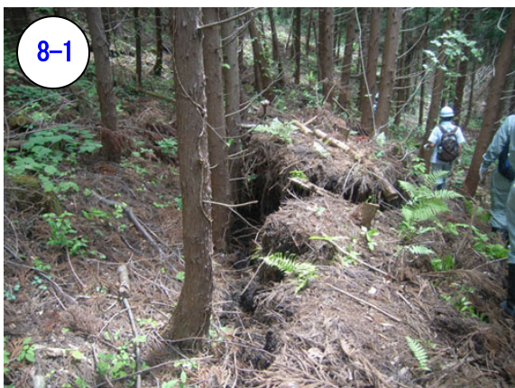
写真-2.18 地すべり背後地に生じた段差 (2008年7月14日撮影)
