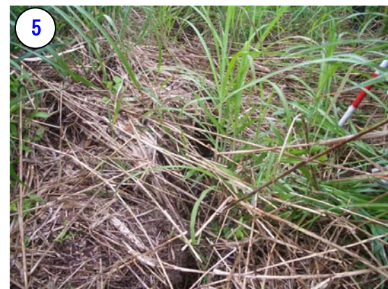
写真-2.15 市道北側の休耕地の連続した新しい 開口亀裂 (2008年6月22日撮影)
