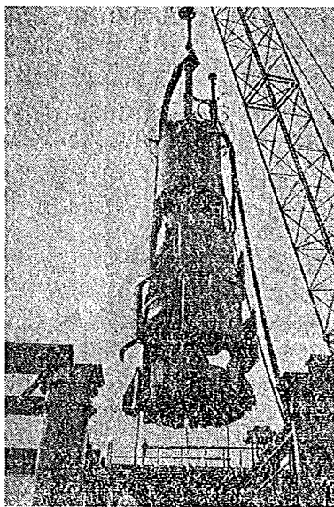
写真-7 土木研究所で開発した大口径掘削機
