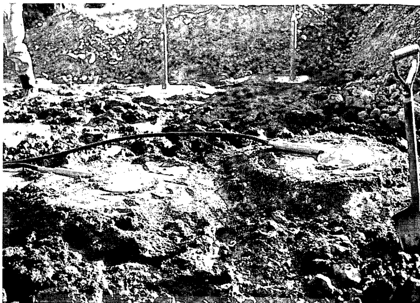
写真-5.3 土圧計設置状況
