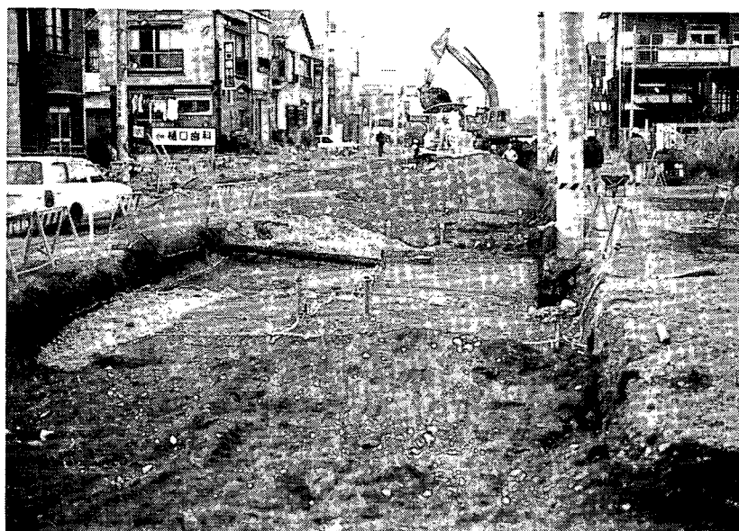
写真-5.4 試験工区施工状況
