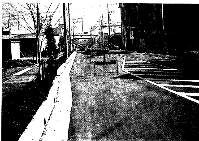
写真-5.5 試験工区完成状況
